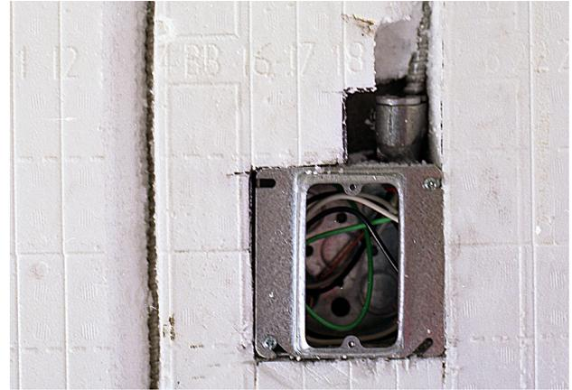
Illustration 11.1.4 Boîtier électrique avec petit passe-fils découpé dans l'isolant.
