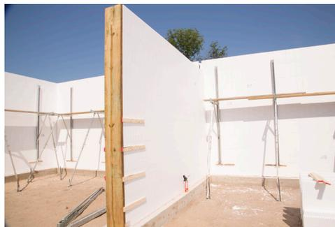
Illustration 5.12.1 Un mur d'extrémité, correctement attaché avant l'installation du système de contreventement/alignement avant le coulage du béton.
