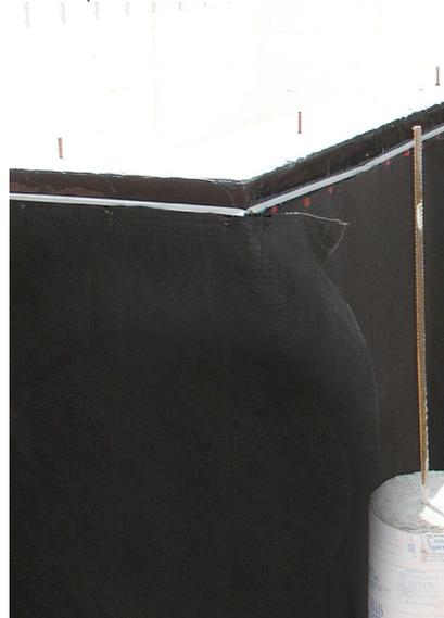
Illustration 6.4.9 Sous-sol avec pilier au-dessus de la semelle. Ceci est fait pour empêcher l'affaissement de la semelle jusqu'à ce que le sol remanié se tasse.
