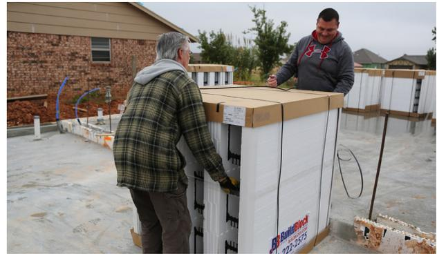
Illustration 1.7.3 Les blocs BuildBlock sont facile à déplacer sur un chantier par une ou deux personnes. Faites glisser; ne roulez pas, pour éviter d'endommager les bordures ou les coins.
