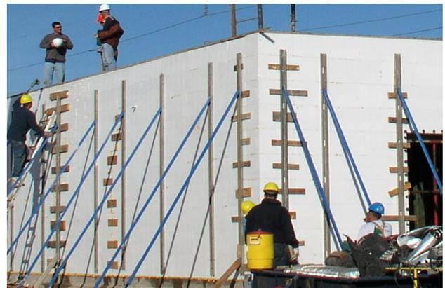
Illustration 9.6.5 Grand renfort extérieur avec des supports sur les joints de blocs irréguliers. Aucun marchepieds.
