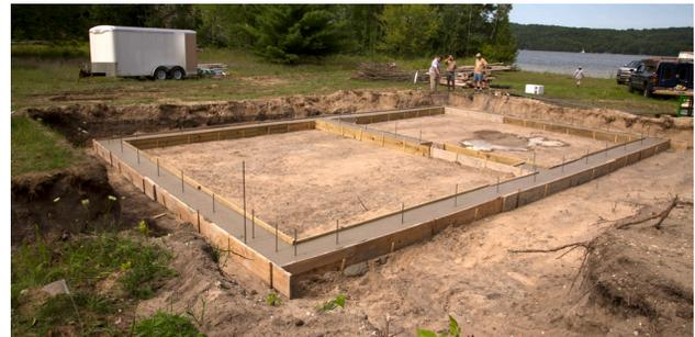
Illustration 4.1.8 Placez des goujons d'armature verticaux avec la hauteur correcte pour rejoindre le mur CIB.
