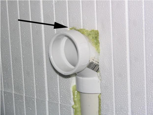
Illustration 11.1.7 Tuyau en PVC de 2" encastré dans un mur CIB.
