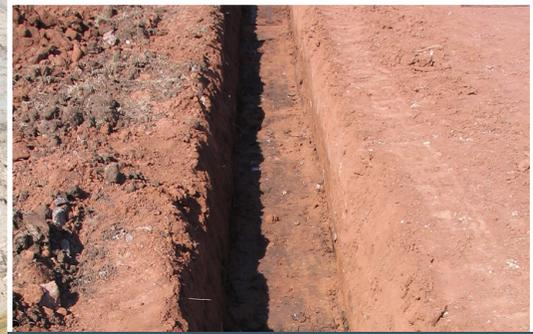
4.4.2 Semelles formées à même la terre avant la mise en place des barres d'armature.
