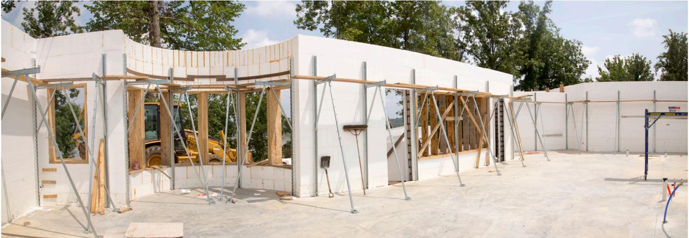
Illustration 8.1.1 Les murs de CIB et les cadres de fenêtres ont été contreventés avant la coulée de béton.
