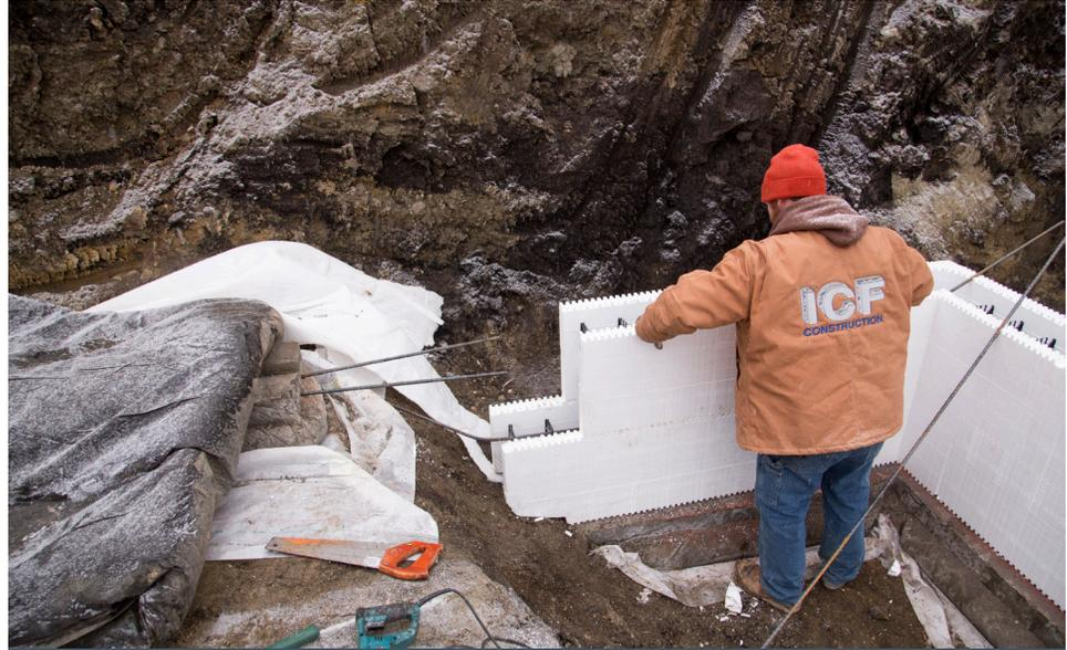
Illustration 4.3.3 Construire une semelle en gradin. Remarquez les barres d'armature horizontales qui s'étendent de la semelle supérieure pour attacher le bloc horizontal à la semelle.
