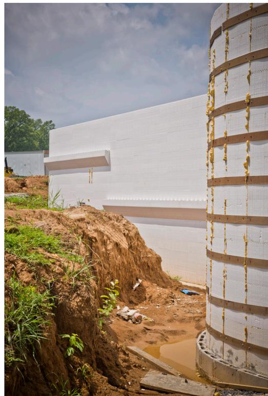
Illustration 6.3.2 Supports à maçonnerie installés à différentes hauteurs pour soutenir la facade en maçonnerie au-dessus du niveau du sol.
