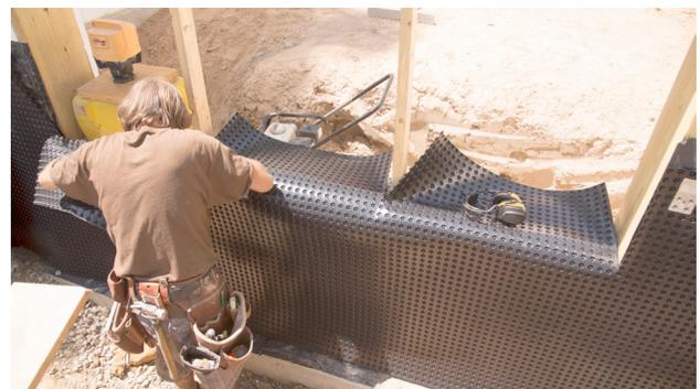
Illustration 6.4.7 Prolongez l'imperméabilisation dans les ouvertures des fenêtres pour empêcher l'humidité de pénétrer.
