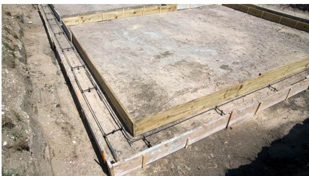
Illustration 4.1.5 Semelles formées avec des barres d'armature horizontales placées selon les codes locaux.
