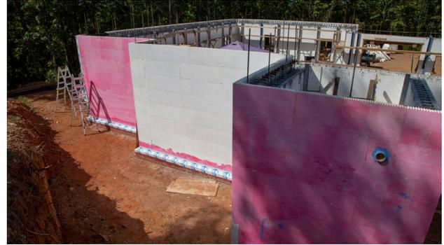
Illustration 6.4.4 Bande de départ fixée le long de la semelle et des coins. Murs partiellement apprêtés pour l'installation de la membrane. Cette dernière est fixée au mur de coffrage et scellée au sommet de la semelle.
