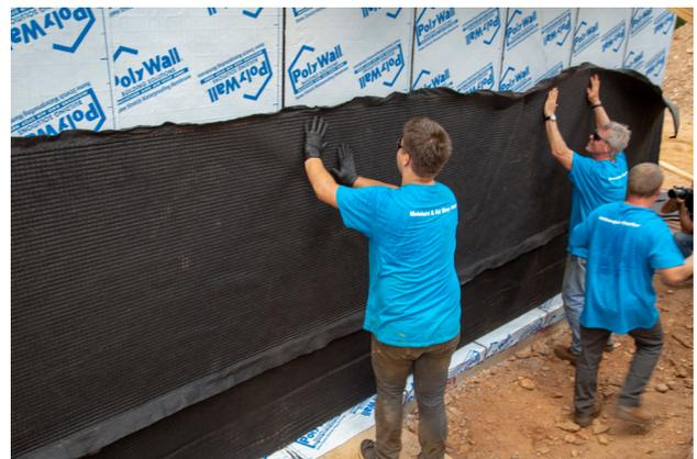
Illustration 6.4.6 Une membrane d'imperméabilisation atvêolée est installée et amenée à au moins 1 pied au-dessus du niveau de remblayage. Se conformer aux codes locaux.
