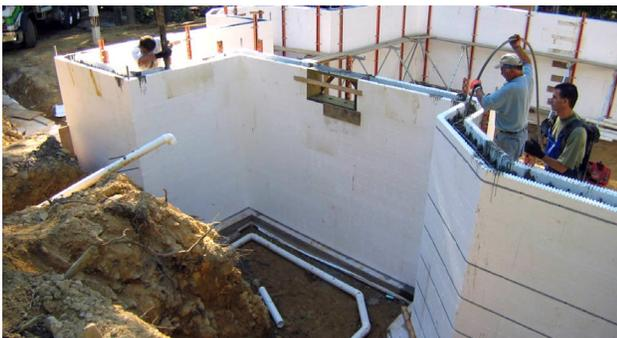
Illustration 6.1.2 Drain français standard utilisant un tuyau de PVC perforé.
