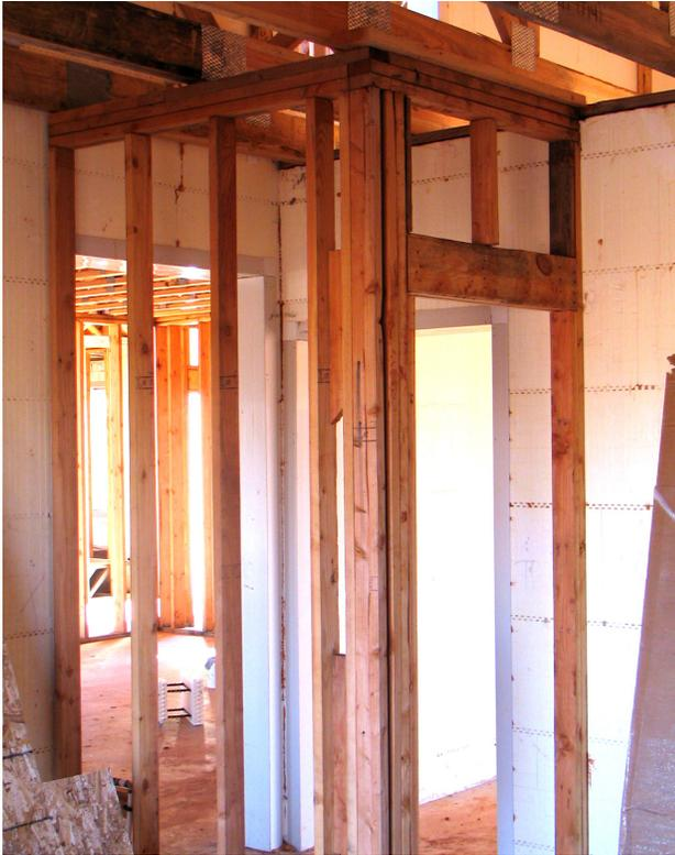
Illustration 11.1.3 La charpente interne en bois est fixée aux murs BuildBlock avec des vis. Les Tapcons peuvent également être utilisés si nécessaire.
