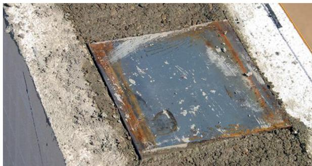
Illustration 5.10.3 Plaque d'appui en acier encastrée en haut d'un mur CIB. S'assurer de la bonne hauteur en tenant compte des connexions de verrouillage.
