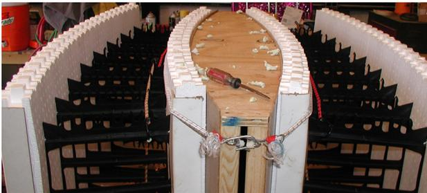
Gabarit de mur arqué maintenant les blocs ensemble pendant la prise de la mousse adhésive. Les blocs peuvent être créés dans un espace de travail climatisé, numérotés et transportés sur un chantier pour accélérer la construction.
