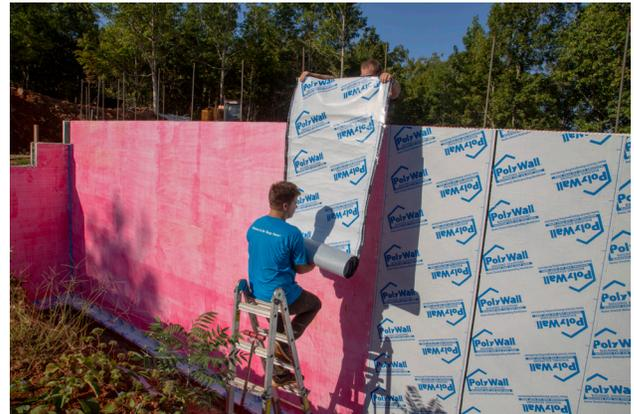
Illustration 6.4.5 La membrane Poly-Wall est installée en chevauchant les joints d'au moins 3 po afin que l'eau s'écoule par-dessus le joint et non contre celui-ci.
