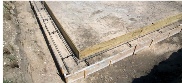
Illustration 4.2.2 Semelles coffrées et armées prêtes à être coulées.
