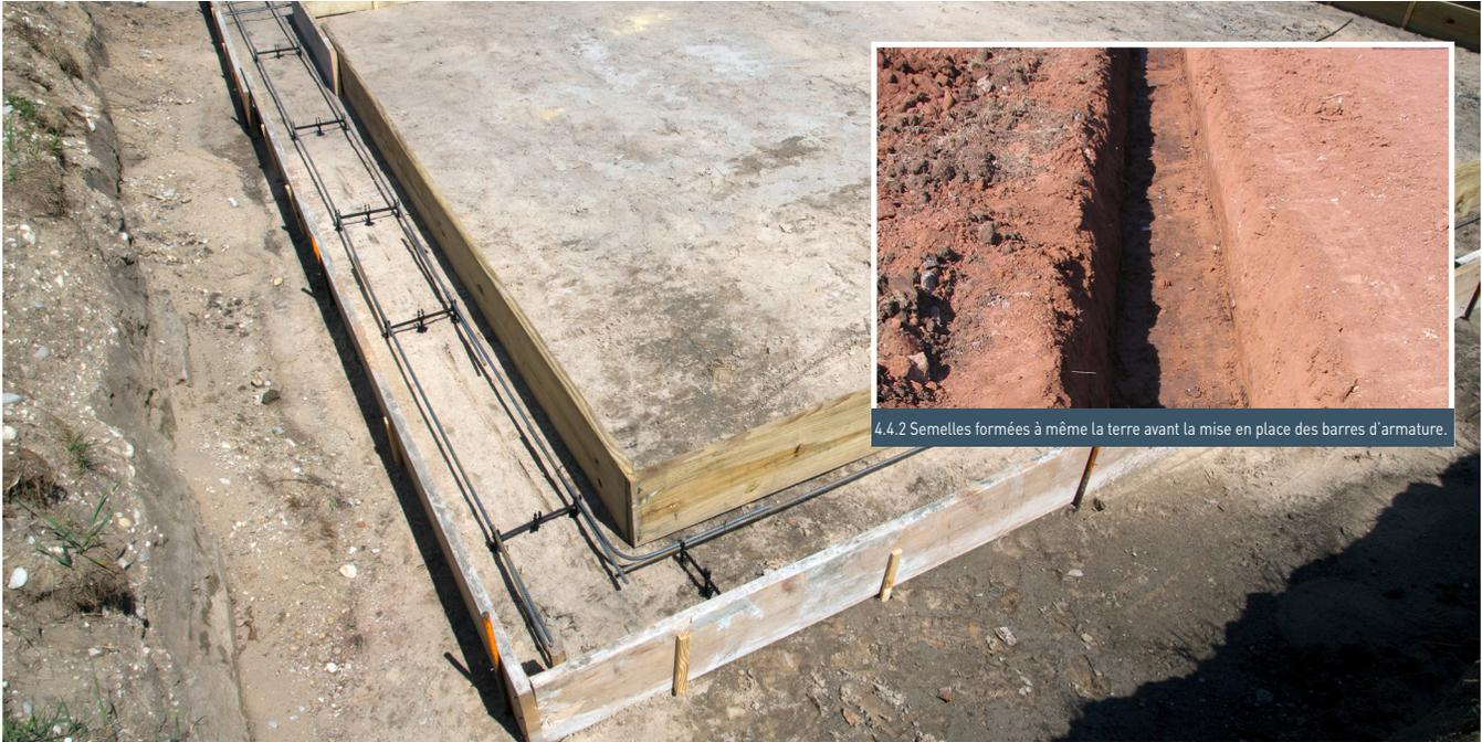
Illustration 4.4.1 Semelles formées avec des barres d'armature horizontales en place.
