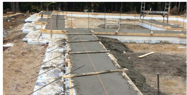
Illustration 6.1.4B Disposition des semelles SR.Footing™ avec des barres d'armature placées et l'isolant au pourtour de celles-ci.
