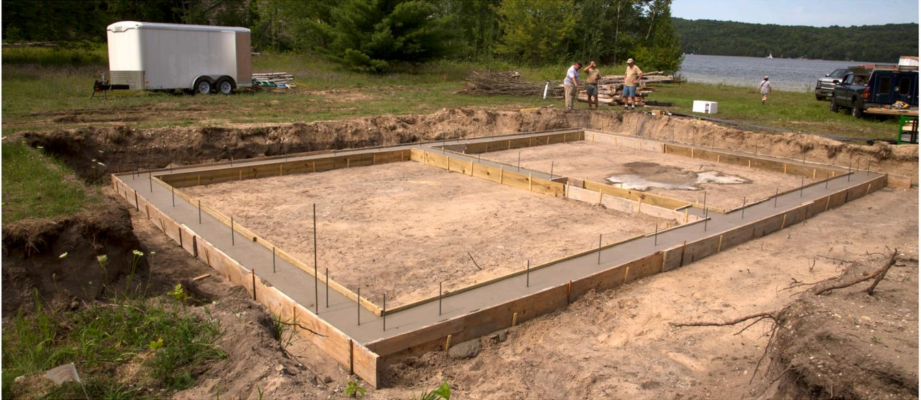
Illustration 4.1.1 Disposition typique des semelles avec goujons d'armature verticaux placés.
