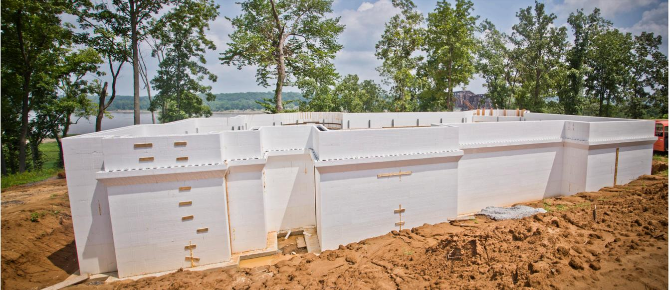
Illustration 6.3.1 Sous-sol en CIB avec support à maçonnerie installé pour soutenir le revêtement de maçonnerie au-dessus du sol.
