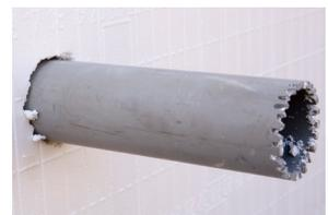
Illustration 7.1.3 Coupez de petites dents à une extrémité du manchon et utilisez-les pour scier l'autre côté du bloc pour créer une ouverture lisse.
