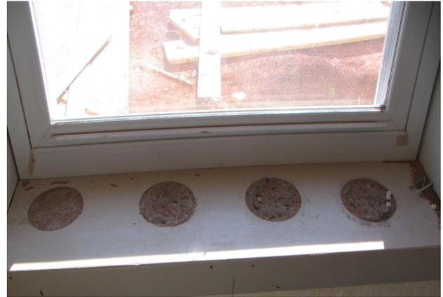
Illustration 8.1.4 Remplissez les trous découpés au bas d'une fenêtre. Assurez-vous que l'air entraîné peut s'échapper lors du coulage d'une fenêtre pour éviter tout vide.
