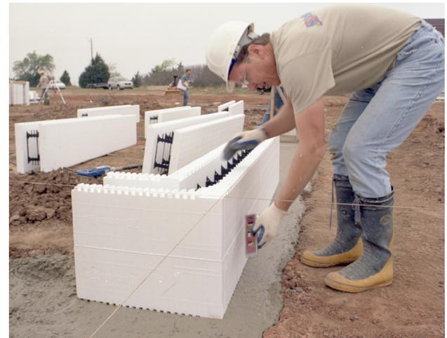
Illustration 4.3.3 Plaçage des formes de coin pendant la méthode à prise-humide. (Voir les détails CAO 6, 7 et 8.)
