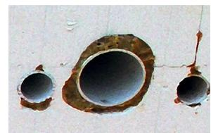
Illustration 7.1.5 Ajoutez des sangles supplémentaires si nécessaire, coupez les tuyaux à ras après la coulée pour une finition homogène.
