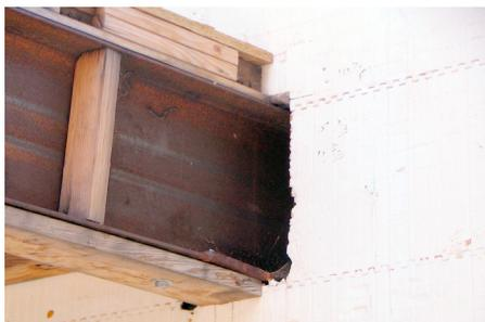
Illustration 5.11.1 Poutre en acier placée dans la réservation de poutre.
