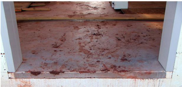
Illustration 8.2.2 Notez le seuil en béton coulé sur le bord extérieur du mur. Le cadrage a été correctement contreventé pendant la coulée pour éviter tout gauchissement. Les portes n'utilisent pas d'arrêt de coulée (cadre) au bas de la porte. Remarquez également la dalle coulée au-dessus du seuil de la porte en coupant le bloc à 1 à 2 po sous la hauteur du sol.
