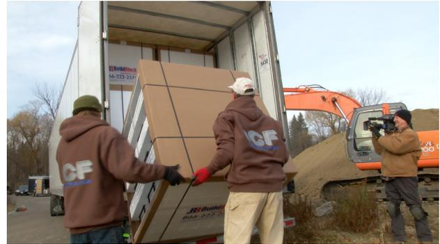
Illustration 1.7.2 Déchargez les blocs BuildBlock à plat pour éviter d'endommager les bords et les coins.
