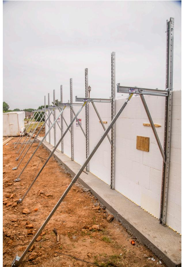
Illustration 4.5.3 Système de contreventement et d'alignement BuildBrace mis en place avec un espacement approprié.
