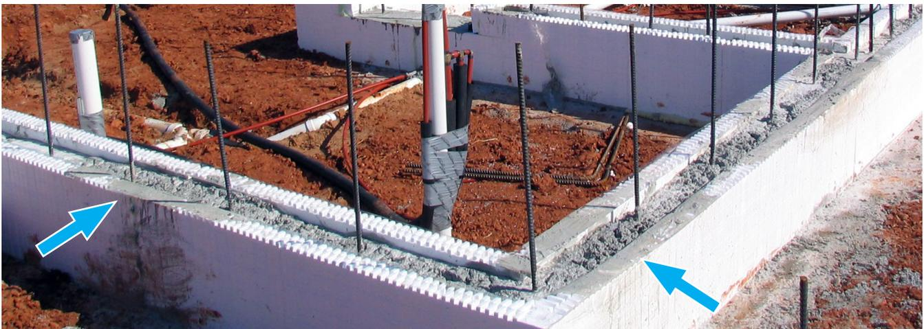
4.4.4 Blocs avec méthode à prise humide placés avec des barres d'armature verticales et horizontales pour les applications de dalle sur sol en conjonction avec la construction de muret. Laissez le béton légèrement rugueux 1-2" sous le dessus des blocs. Protéger les connexions de verrouillage de blocs pour continuer à empiler des rangées supplémentaires.
