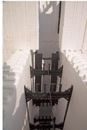
Illustration 5.5.6 Ouverture de mur en T avec fil utilisé pour fixer les attaches du bloc avec celles du bloc en T.
