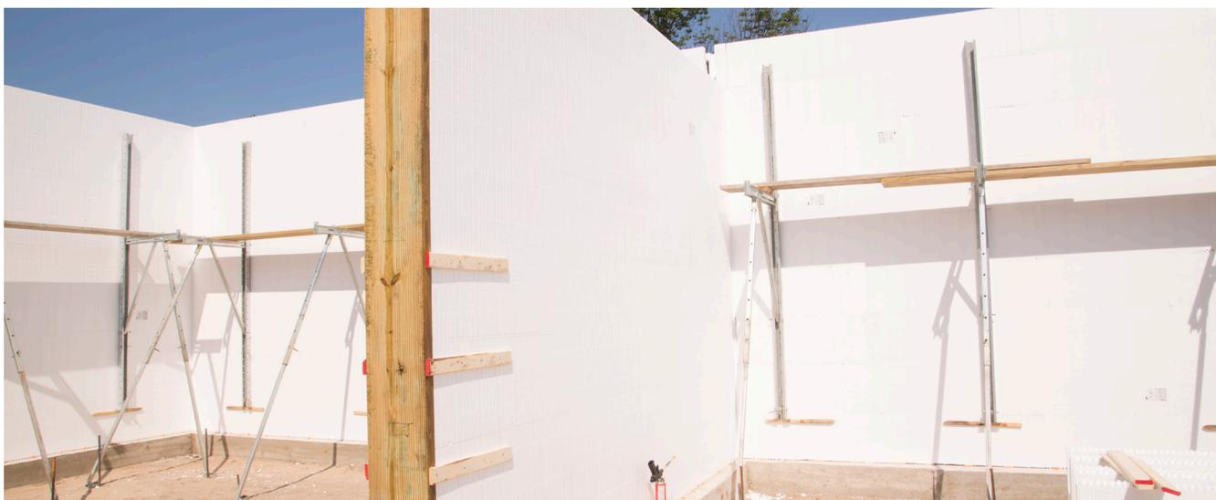
Illustration 6.2.1 Sous-Sol et garage en coffrage de béton isolé, contreventé et coulé.
