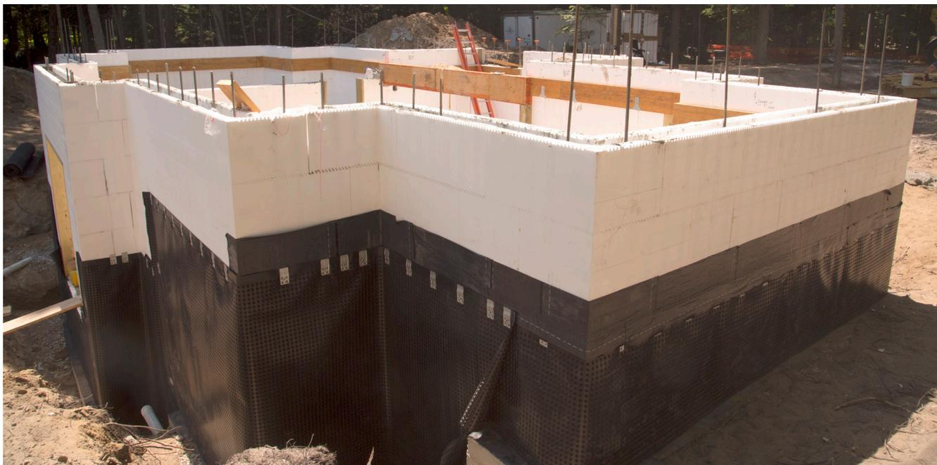
Illustration 6.4.1 Murs CIB au-dessous du niveau du sol avec membrane d'imperméabilisation autocollante appliquée et barrière alvéolé pour éviter les dommages causés par le remblayage et fournir un soulagement de la pression hydrostatique.
