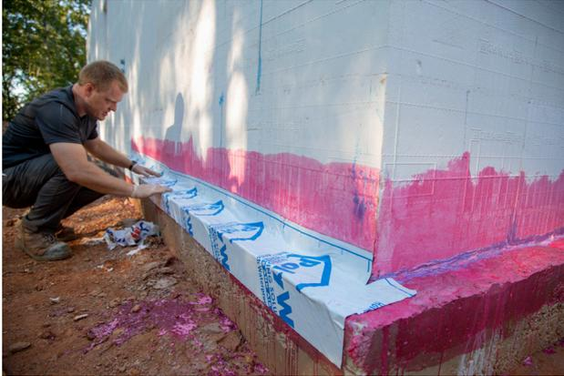
Illustration 6.4.3 Installateur plaçant une membrane d'étanchéité autocollante. Remarquez les 12" de membrane au bas du mur scellant la semelle au mur.
