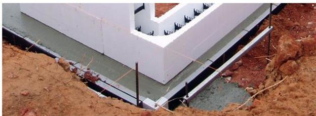
Illustration 6.1.5 Les lignes de corde sont utilisées pour garantir l'équerrage et le bloc au-dessus du coin verrouille le coin en place jusqu'à ce qu'elles soient fixées.
