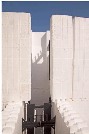
Illustration 5.5.5 Ouverture de mur en T en alternant le placement de bloc.
