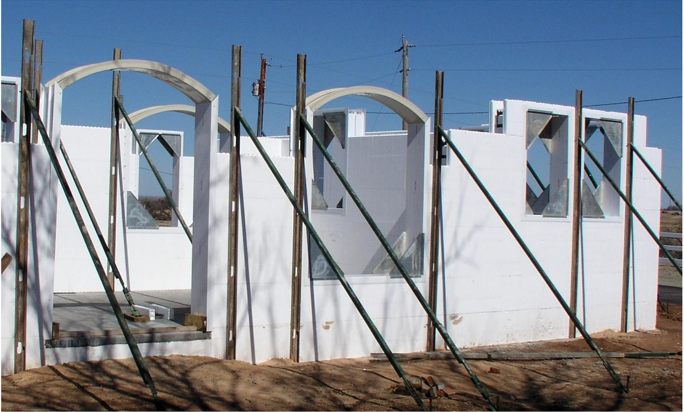
Illustration 8.5.1 Les fenêtres et portes cintrées s'intègrent facilement dans les murs BuildBlock.
