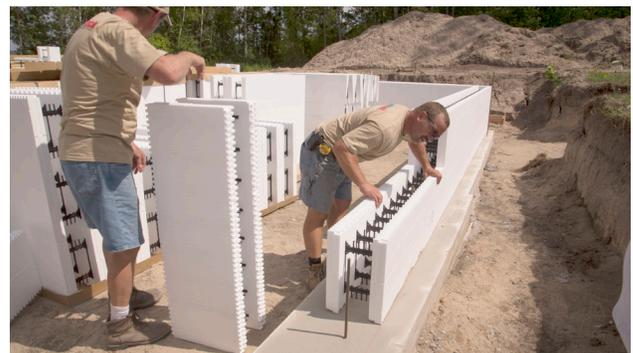
Illustration 4.1.9 Une finition de niveau lisse facilitera l'empilement et le nivellement du mur CIB.
