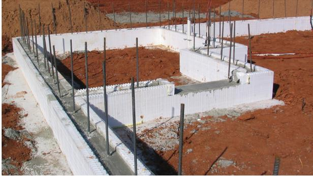
Illustration 4.3.4 Muret BuildBlock avec technique à prise humide. La première rangée est alignée, empilée et coulée. Le site est maintenant prêt pour la coulée de la dalle. Remarquez les barres d'armature s'étendant sur au moins 24" à la verticale et les connexions de verrouillage propres afin que le prochain rang puisse être empilé.
